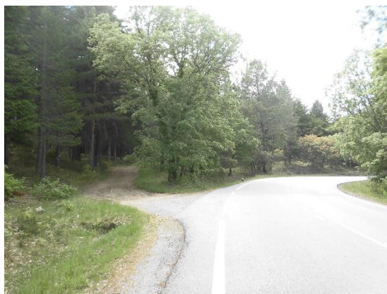
Figura 9 – Vista para o Cruzamento VCMB - 2
