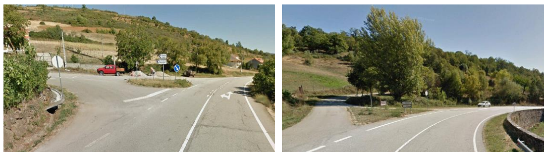
Figura 6 – Entroncamento com a EM505 (foto esquerda) e entroncamento com o CM1017 (foto direita).
